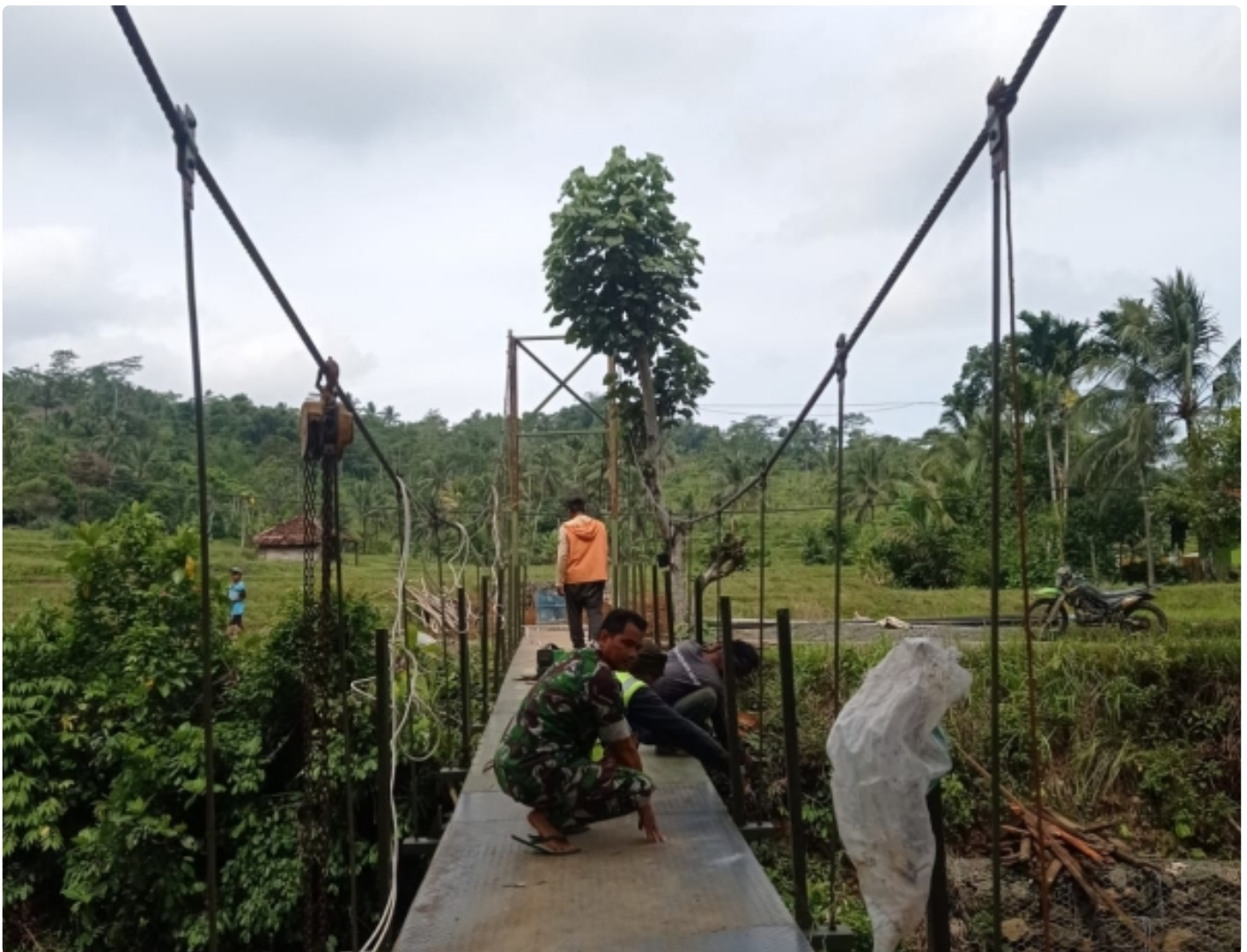
Kpt Arm Witono: Pengerjaan Jembatan Gantung Sudah 80%
