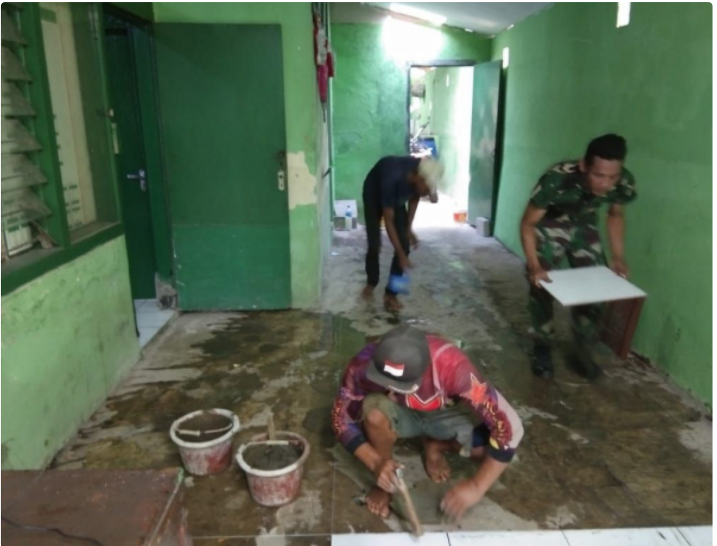
Koramil 0622-04/Cikidang Lakukan Perbaikan dan Pemeliharaan Kantornya
